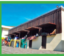
Revitalização do Largo dos Padeiros Paranapiacaba (meta 65: revitalizar 60 imóveis e promover ações de manutenção e salvaguarda de 20% do patrimônio histórico edificado da Vila de Paranapiacaba)
