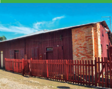
Recuperação do Imóvel rua Direita - Paranapiacaba (meta 65: revitalizar 60 imóveis e promover ações de manutenção e salvaguarda de 20% do patrimônio histórico edificado da Vila de Paranapiacaba)
